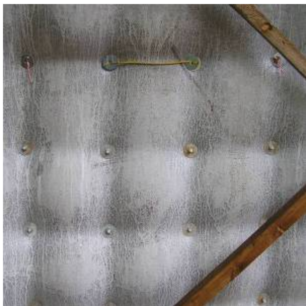
Completed Concrete Pour
