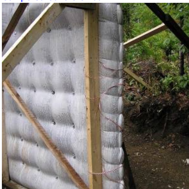
Completed Concrete Pour
