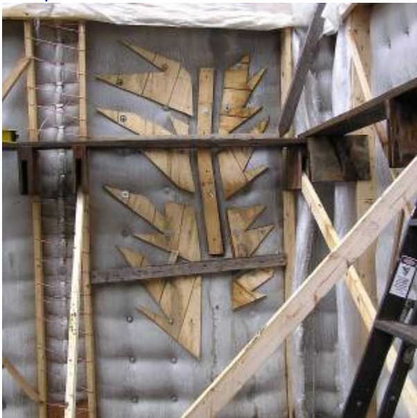
Completed Concrete Pour
