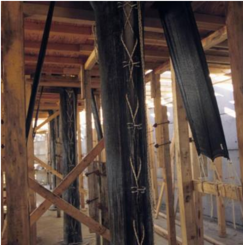
Fig. 16. Casa Dent - a private villa in Culebra, Puerto Rico.
