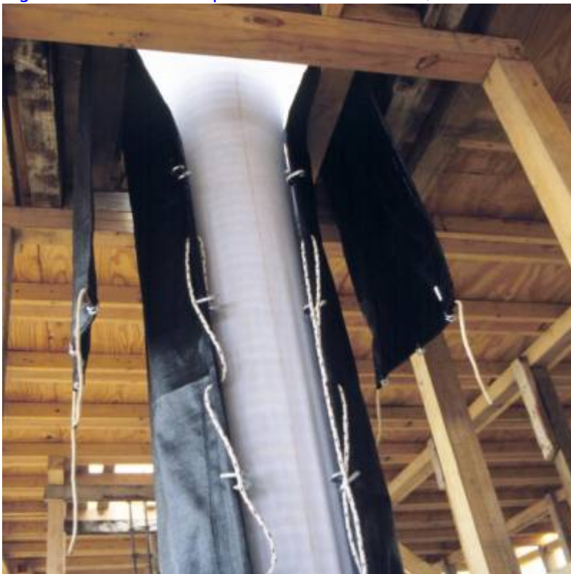
Fig. 17. Casa Dent - a private villa in Culebra, Puerto Rico.
