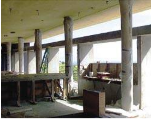
Fig. 20. Casa Dent - a private villa in Culebra, Puerto Rico.
