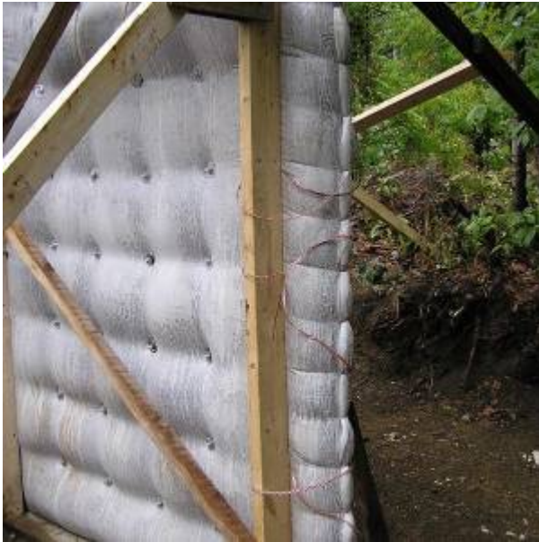
Fig. 16. Completed Concrete Pour
