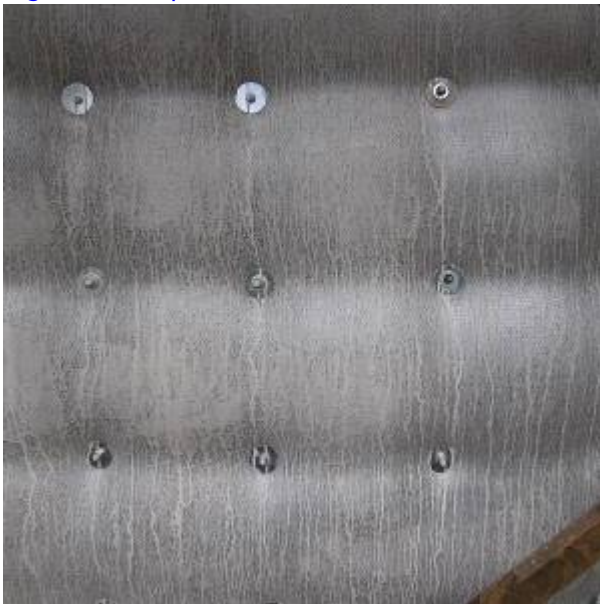
Fig. 17. Completed Concrete Pour
