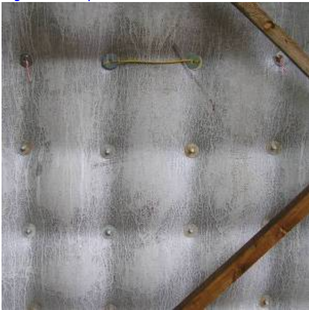
Completed Concrete Pour
