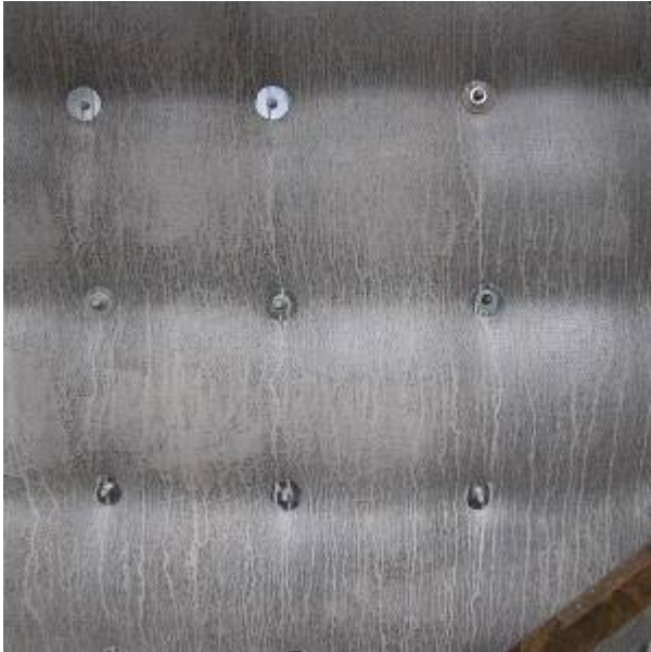
Fig. 17. Completed Concrete Pour
