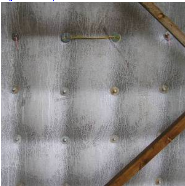
Completed Concrete Pour
